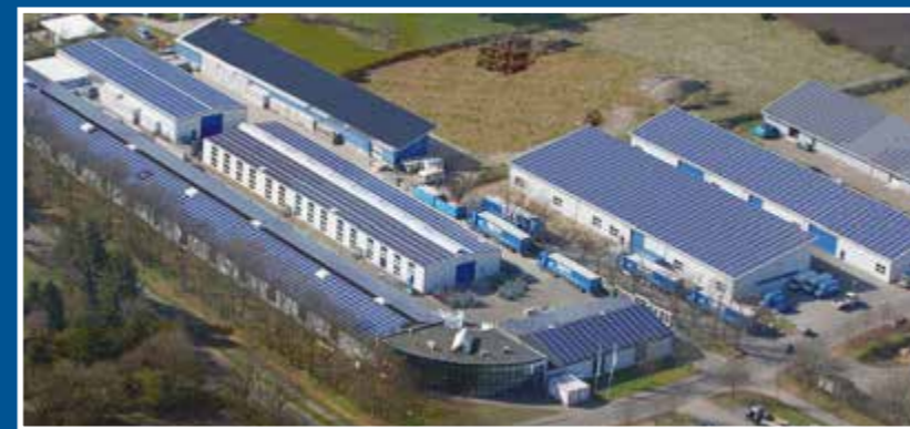
BALTIC Fenster GmbH · Hohe Koppel 1 · D-25842 Langenhorn · Tel. 0 46 72 / 77 37-0
